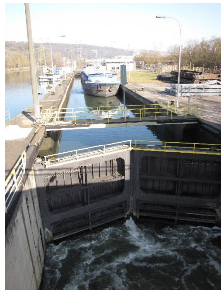
Foto der Neckarschleuse in Deizasau
